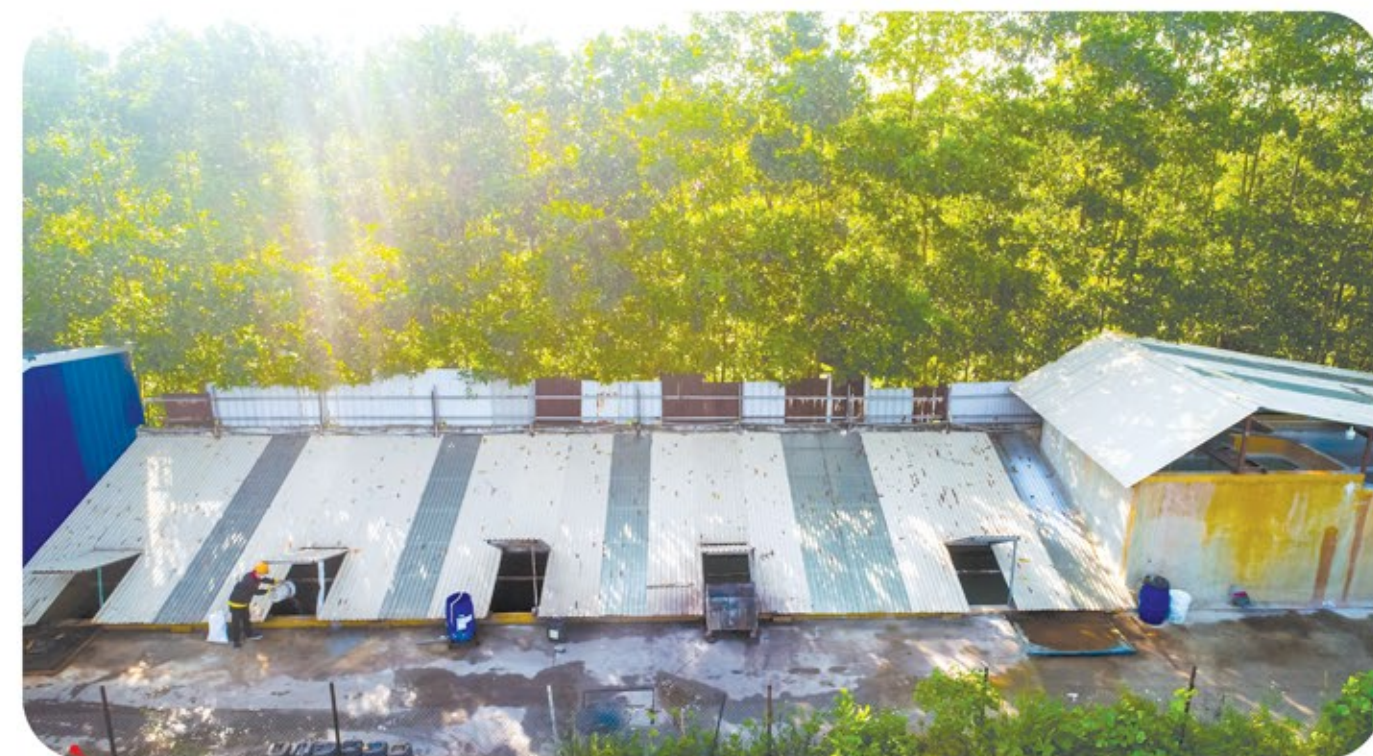
Khu xử lý nước thải
